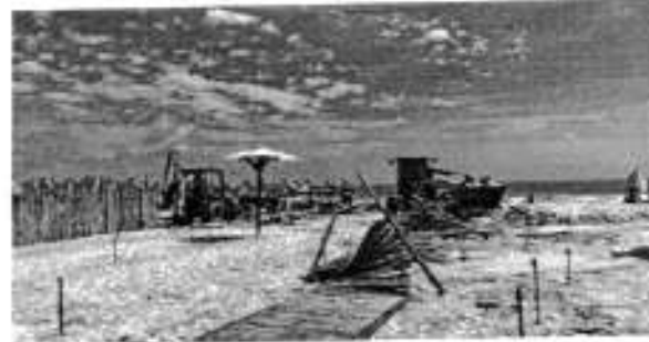
DEMOLIÇÃO ANDOU A UM PEDIDO DO MPF
